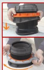
3. Introduire le raccord dans le trou, guider le joint et pousser à fond jusqu'à faire coïncider la paroi du tube et celle du raccord.
