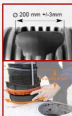
1. Percer un trou dans la partie supérieure du collecteur de 200±3mm.
